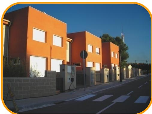
GICSA construit 23 pavillons jumeaux divisés en groupe de 3,4 et 6 unités. La superficie construite de ce complexe résidentiel est de 3.472 m<sup>2</sup>. Les pavillons ont une superficie de 150 m<sup>2</sup>, divisés en deux étages sur niveau.
