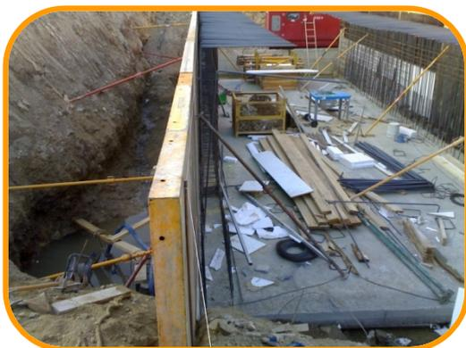
Sur commande de la municipalité de Salou, une structure de canalisation des eaux de pluie va être construite. Cette structure, de 5 mètres de largeur libre et de 2,2 mètres de gabarit, va s'exécuter grâce à une poussée, sous la voie ferrée et canaliser les eaux du Barranco de Barenys jusqu'à son embouchure, sur la plage de Ponent.
