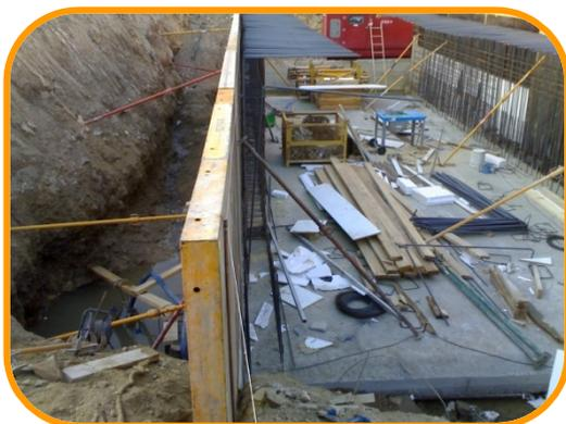
По заказу Мэрии Салоу была выполнена структура канализации дождевых вод. Эта структура шириной 5 м и высотой 2,2 м устанавливается под железнодорожным полотном и канализирует воды Оврага Баренис до их впадения на Пляже де Понент.
