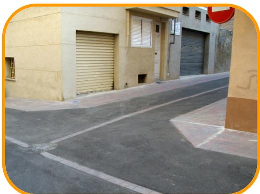
ЖИКСА выполнила работы по восстановлению старого центра Морей. Речь идет об участке, расположенном на площади 6.200 м<sup>2</sup>, из них на 3.200 м<sup>2</sup> был положен асфальтовый агломерат, и на 3.000 м<sup>2</sup> бетонный настил.
