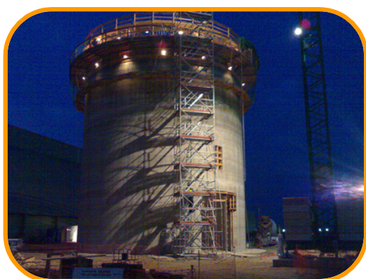
COFRAGEM DESLIZANTE, DE CONSTRUÇÃO CONTÍNUA
