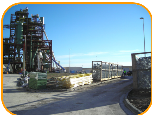
VIA ADAPTADA AO TRÁFEGO DE VEÍCULOS PESADOS
