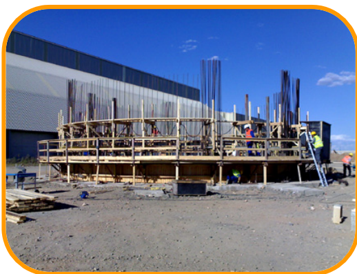
PRIMEIRA FASE DAS OBRAS DE CONSTRUÇÃO
