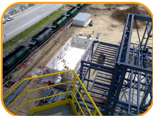
VISTA ÁREA DA CABINE DE CONTROLO
