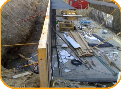
تم بناء و بتكليف من بلدية سلوو، لهيكل توجيه مياه الامطار. وهذا الهيكل الذي يبلغ عرضه 5 أمتار و علوه 2،2 مترين، تم تنفيذ أشغاله عن طريق تقنية الدفع تحت خطوط السكك الحديدية ويقوم بتوجيه مياه وهد برينس إلى حتى مكان مصبه بشاطئ بنينت.
