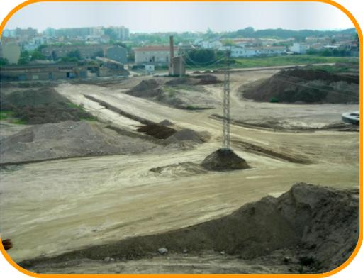
أشغال التجهيز والتنظيم التي تم تنفيذها بالتعويض، شملت تعبيد الشوارع (28.000 متر مربع)، حدائق المساحات الخضراء (5.000 متر مربع) و التجهيز بالخدمات الحضرية (شبكة المجاري، شبكة مياه المطر، الإتصالات الماء الصالح للشرب، الشبكة الكهربائية ذات الضغط المنخفض و المتوسط و شبكة الغاز الطبيعي). و نقوم أيضا بإنشاء حاويات مضمورة للإنتقاء الإختياري للنفايات.
